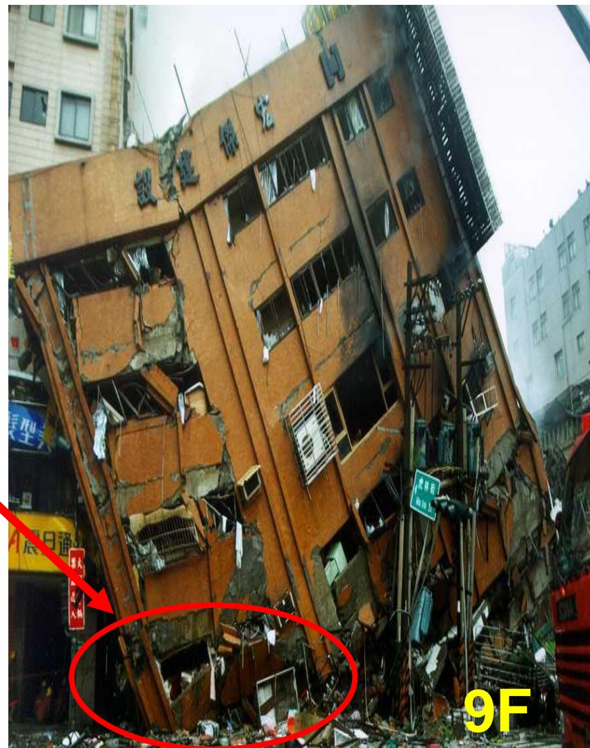
台北市八德路四段虎林街口東興大樓 921地震發生前、後正面照片
